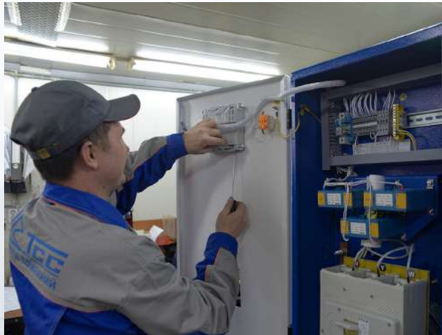
СБОРКА ЩИТОВ УПРАВЛЕНИЯ
