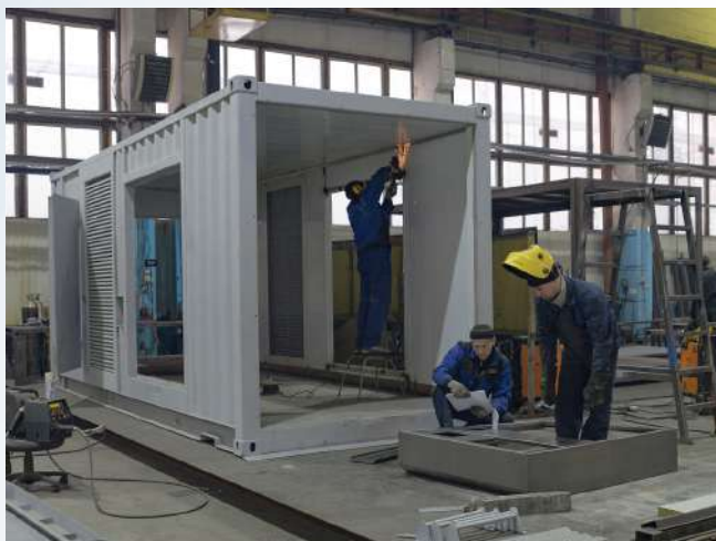
ЦЕХ ИЗГОТОВЛЕНИЯ КОНТЕЙНЕРОВ
